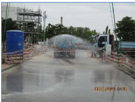
ภาพที่ 2-1 การฉีดพรมน้ำบริเวณพื้นที่ก่อสร้าง และถนนทางเข้าพื้นที่ก่อสร้าง
