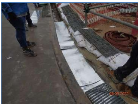
ภาพที่ 2-6 รางระบายน้ำฝนในพื้นที่ก่อสร้าง
