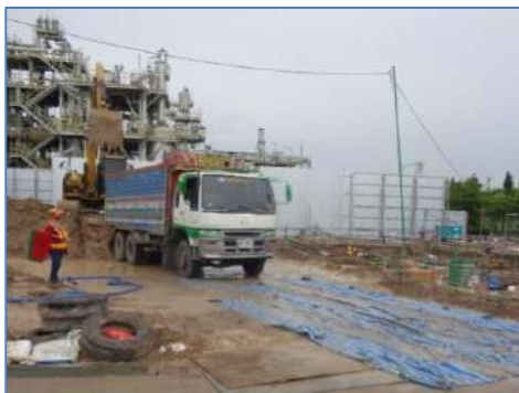
ภาพที่ 2-10 การทำความสะอาดล้อรถบรรทุก / กำหนดจุดล้างล้อรถ
